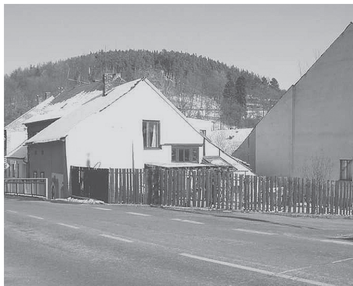
Celý blok domů vpravo od silnice je projektem určen k demolici (7 objektů) - příklad postoje samosprávy k občanům.
